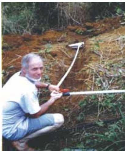
David Hosick pokládá vodovodní potrubí
